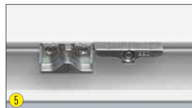
5 Incontro superiore con sistema di microventilazione.
