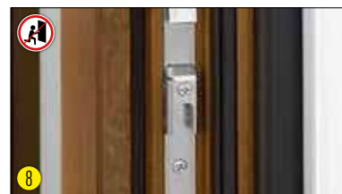
Incontro antieffrazione presente sulla ferramenta anta secondaria.
