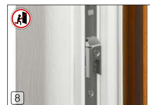
Incontro antieffrazione presente sulla ferramenta anta secondaria.
