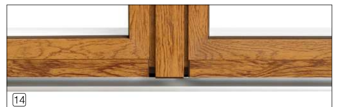
14 Vista esterna, nodo centrale inferiore portafinestra 2 ante. Soglia ribassata in alluminio - PVC e gocciolatoio ossidato argento con tappi di finitura laterali e centrali in tinta.
